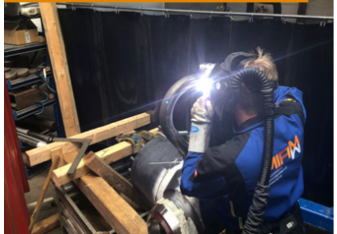
Schweißen eines Bypasses an einem Hochdruckschieber
